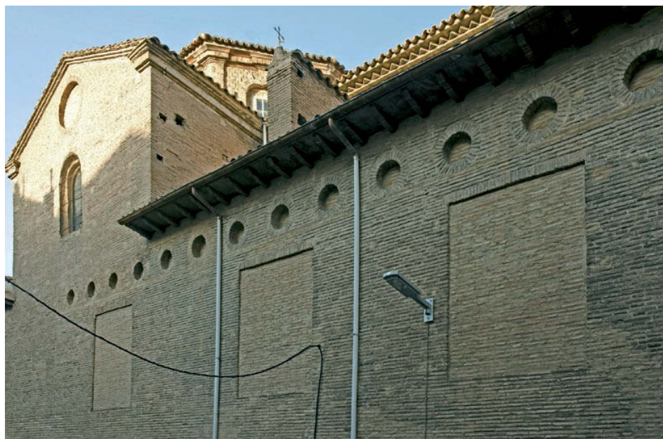
Fig. 5. Imagen del exterior de la iglesia del antiguo colegio de la Compañía de Jesús hacia la calle de Tudela en la que se distinguen los restos de los muros de la vivienda de Hernando Cunchillos. Foto: Rafael Lapuente.
