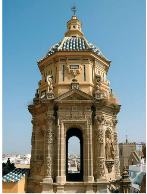
Fig. 16. Sevilla. Iglesia de San Luis de los Franceses. Torre.
